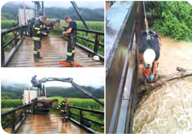
Rotter wurde, gesichert von Kameradschaftsführer Christopher Nott, von der Brücke zu einem angeschwemmten und verkeilten Baumstamm abgeseilt. Mit der Motorsäge wurde der Stamm zerteilt und mit einem LKW-Kran der Firma Binter aus der tosenden Gurk gehievt.
